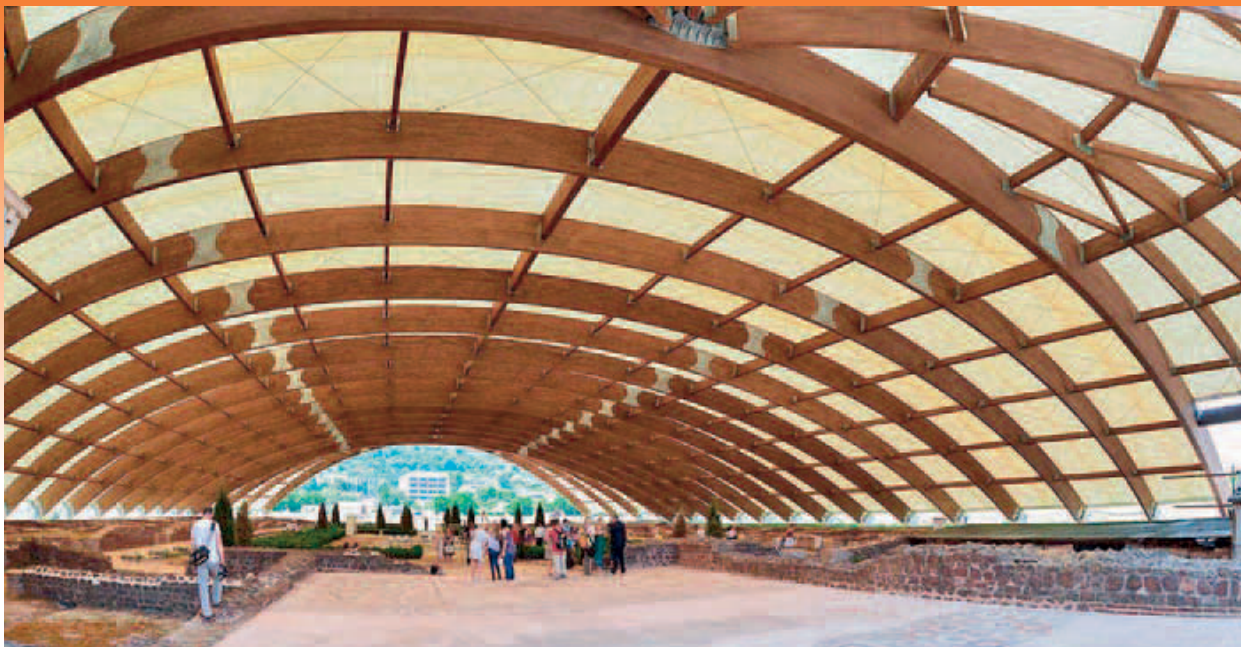
Slika 5. Arheološko nalazište Medijana, krovni nosači su od drveta u rasponu od 72,5 metara, proizvod kompanije PIRAMIDA iz Sremske Mitrovice
