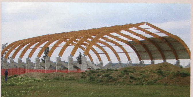
Krovna konstrukcija na objektu u Grockoj
