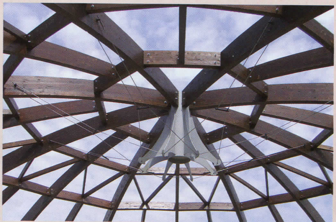
Krovna konstrukcija na objektu u Beogradu
