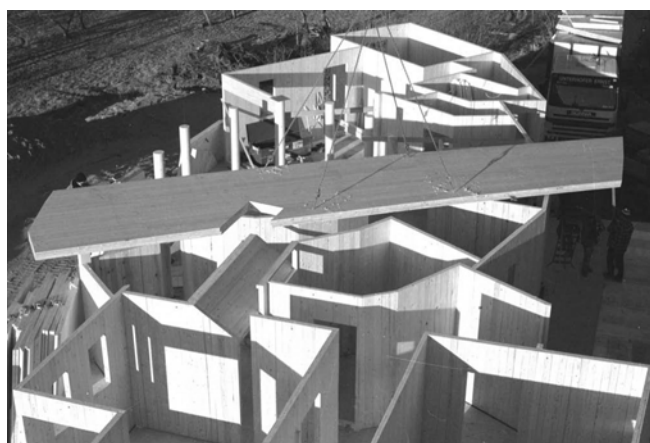
Slika 2. CLT konstrukcija [2] Figure 2. CLT construction [2]
