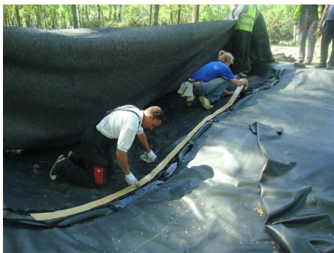
Sl. 8: Postavljanje geotekstila
