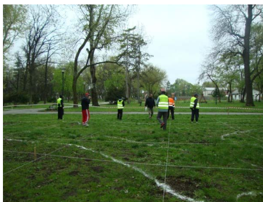
Сл. 5-6: Пrenošenje пројекта на терен
