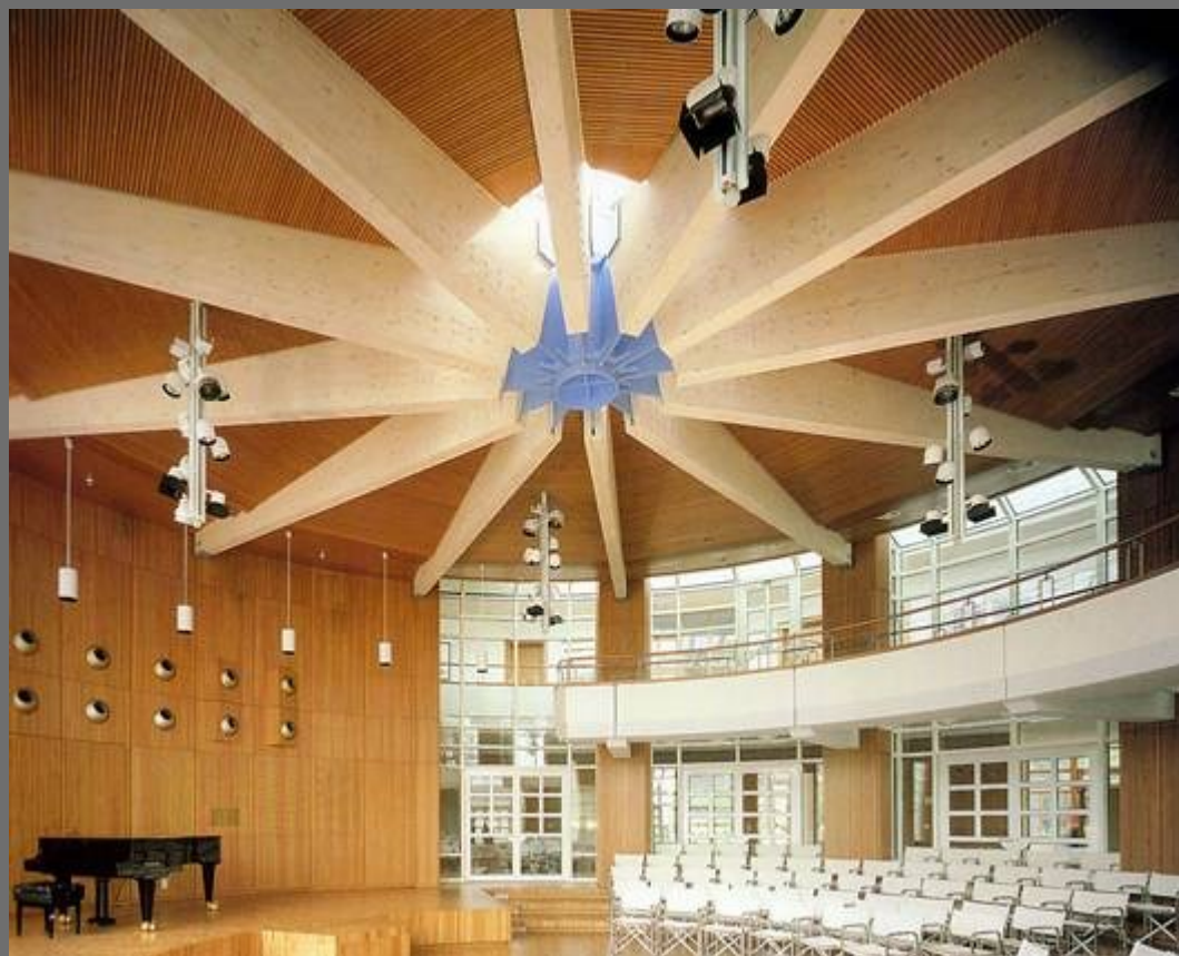
krovná konstrukcija, drvo u kombinaciji sa čelikom
